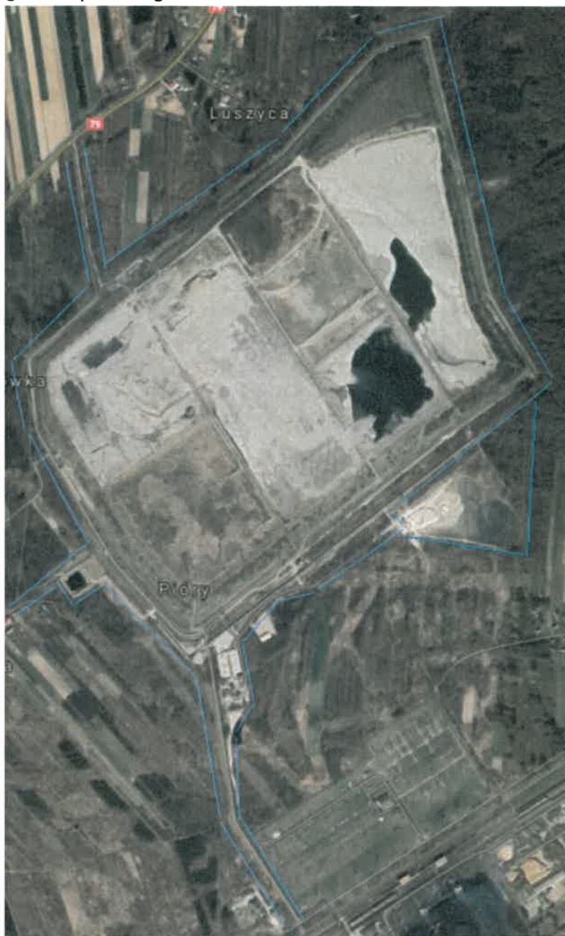
Rys. 1. Teren składowiska „Pióry” i magazynu „Tursko”.
